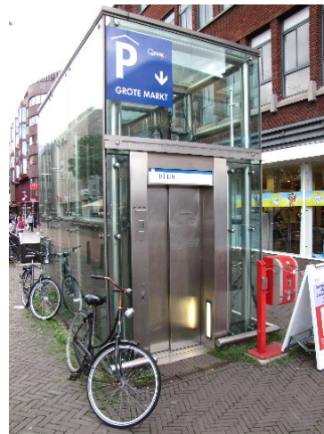
Blindengeleidelijn bij lift C naar gevel Albert Heijn ontbreekt
