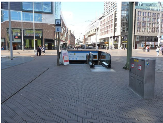
Blindengeleidelijn bij trap K naar gevel Stadhuis ontbreekt
