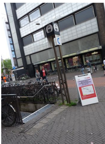
Tweede rij noppentegels ontbreekt
