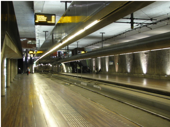
Contrast is te gering, o.a. doordat de witte stippen te veel vervuild zijn
